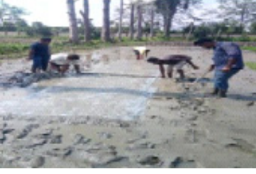
ফুটা থকা প্লাষ্টিক এখন পাৰি তাৰ ওপৰেৰে কাঠৰ বাটাম এডাল চোচবাই নিলে আৱদ্ধ বায়ুখিনি ওলাই যায়
